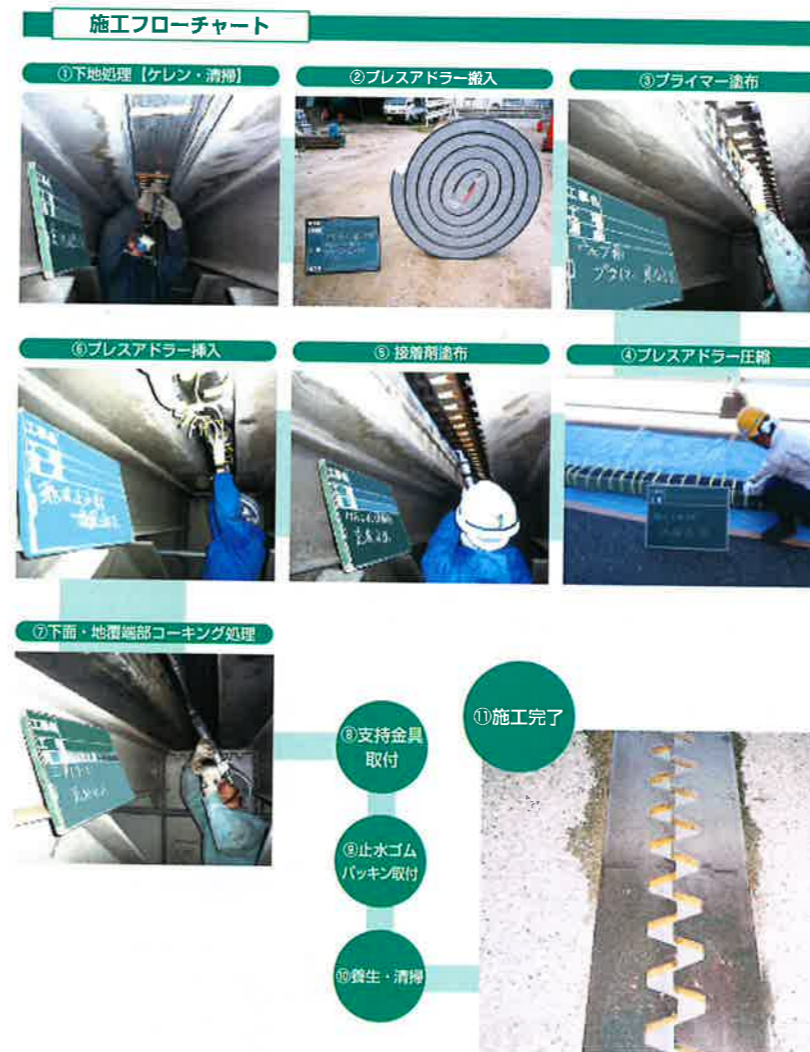
図2: プレスアドラー施工の流れ
