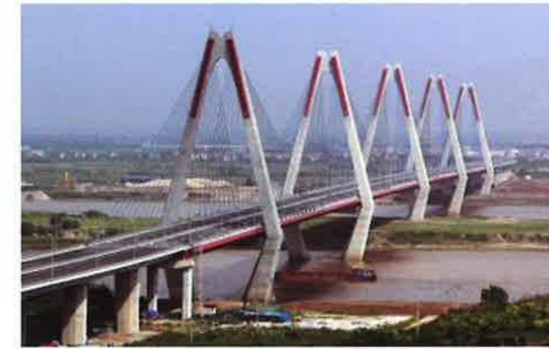
写真-5 ニャッタン橋
