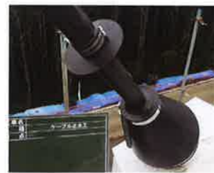
写真-2 ケーブルハットとケーブルゴムカバー
