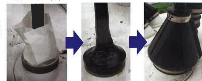
シート巻き 防蝕テープ巻き カバー設置
