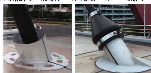
口金設置+防水シール
