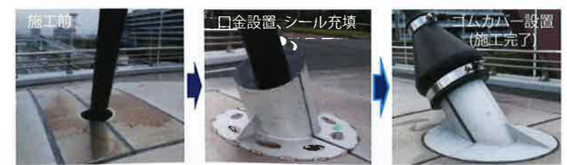
ケーブル定着部の防水補修一貫対応例
