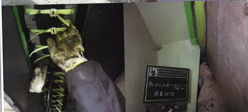
伸縮装置直下からの設置作業の様子 (左:プレスアドラー、右:プチアドラーα)
