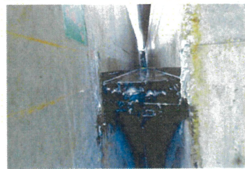
3eシール充填設置完了断面。上方の明かりは、夜間施工のため照明として渡したLEDチューブライト。充填物の下にはうっすらとシール材の型枠（漏れ止め）に使ったバルーンが見える
