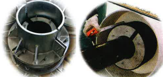
ケーブル制振材「リングダンパー」 プレキャスト型 現場設置型
