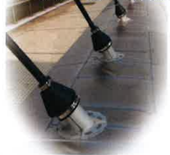
ケーブル定着部防水対策 「ケーブルゴムカバー+口金」
