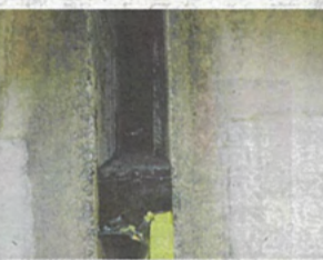
施工完了状況
