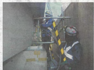
充填施工状況
