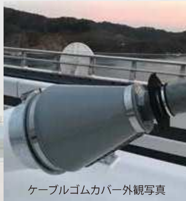
角折れ緩衝材によるケーブル定着点の角折れ抑制イメージ
