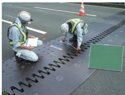
写真-1 伸縮装置調査状況
