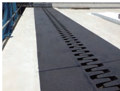
写真-2 摩擦素子コート工
